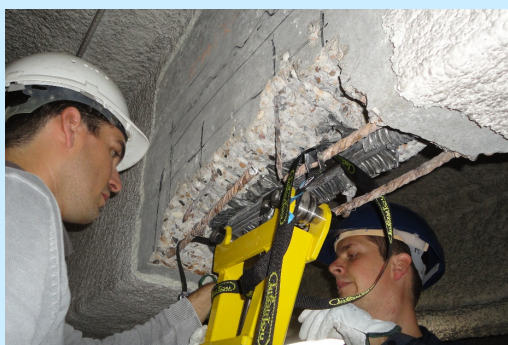
Figure n°1 : Mise en place de l'arbalète
