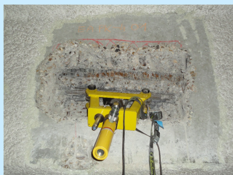
Figure n°2 : Arbalète en place
