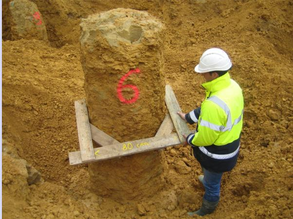
Figure n°1 : tête de colonne décaissée
